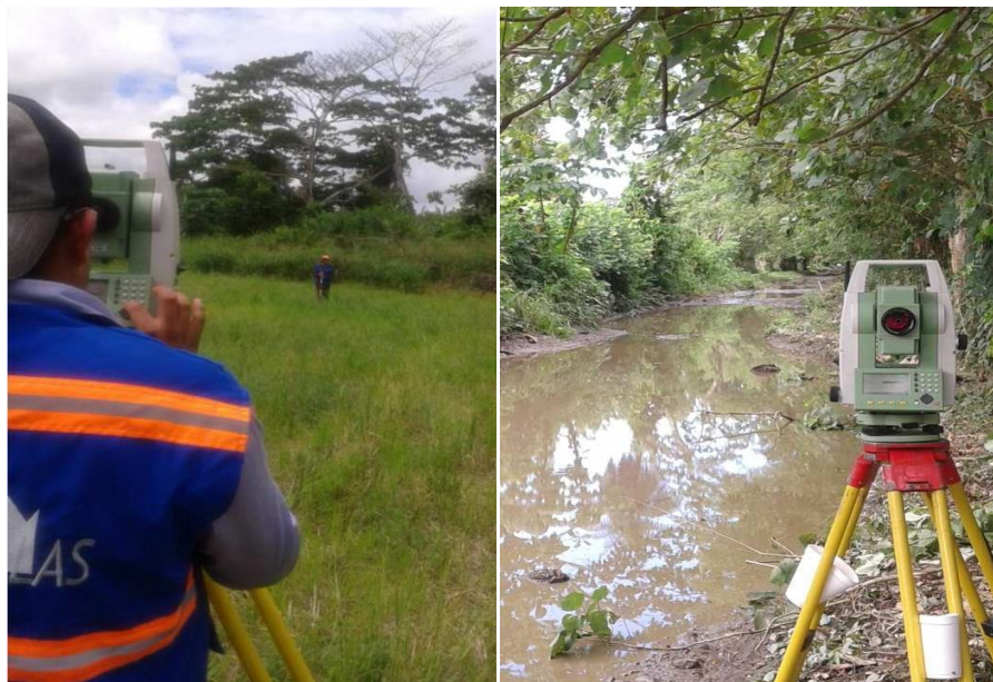
FIGURA 5- LEVANTAMIENTO TOPOGRAFICO CON ESTACION TOTAL EN SOL DAVID Y CALDERA SOLAR
