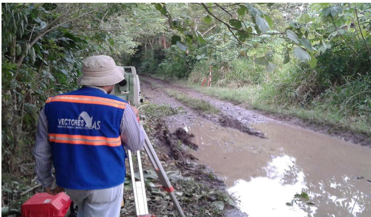
FIGURA 2.-LEVANTAMIENTO ESTACION TOTAL
